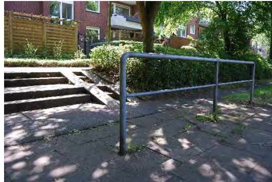
Abbildung 17 Treppenstufen als Barriere Quelle: BIG Städtebau
