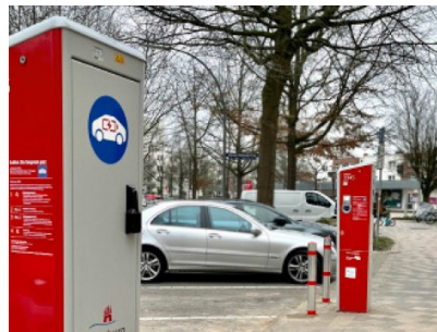
Aufstellung von E-Lade-Säulen
